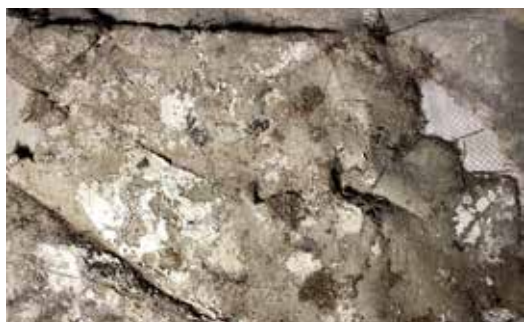
Fig. 10. Particolare, attacco biologico sul retro del supporto.
