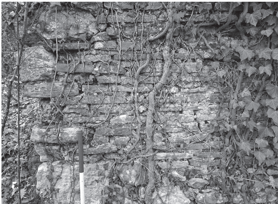
Fig. 7 - Ciciliano, chiesa di S. Magno: muratura della facciata (foto di A. Vella, 2025).
